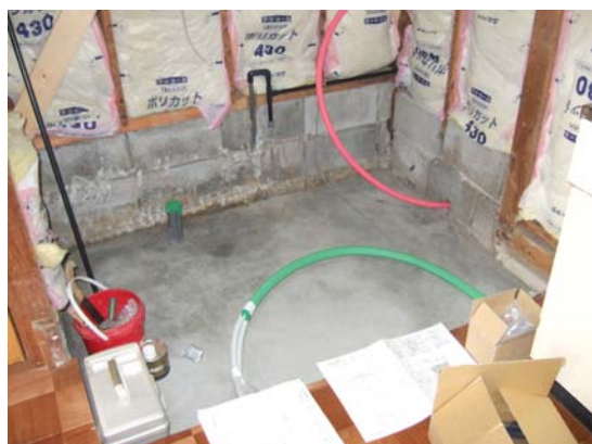
エイトを据える為のコンクリート
